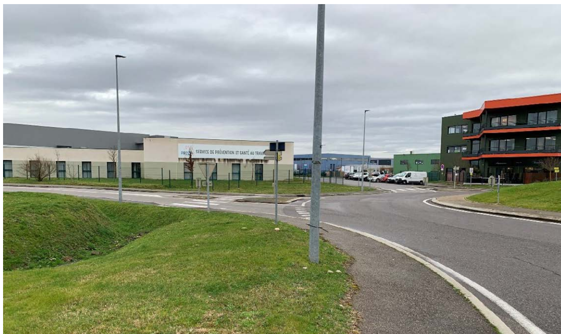
Vue sur le trottoir existant reliant la zone artisanale à l'Est et le Technoparc Source : photographie prise par le commissaire enquêteur
