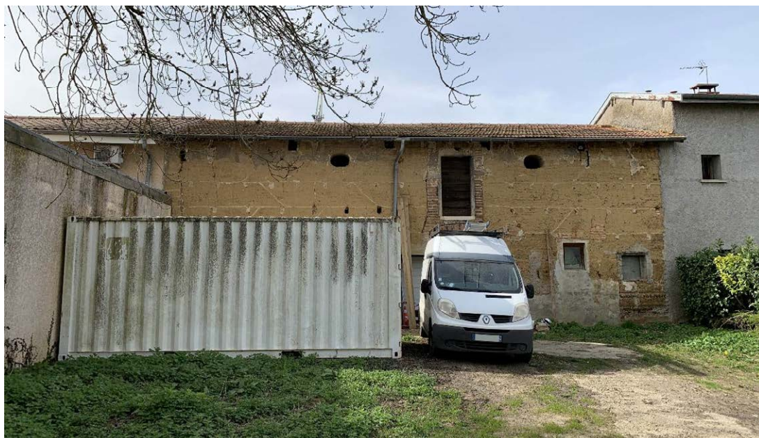
Vue sur le bâtiment dont l'identification est demandée, depuis le chemin de desserte accessible par le chemin de Grande Fagne Source : photographie prise par le commissaire enquêteur
