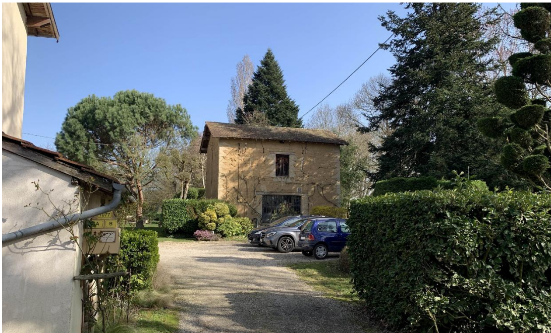
Vue sur le second bâtiment dont l'identification est demandée dans le cadre d'une contribution, à « En Rozier », depuis le chemin de l'Etang Dent Source : photographie prise par le commissaire enquêteur
