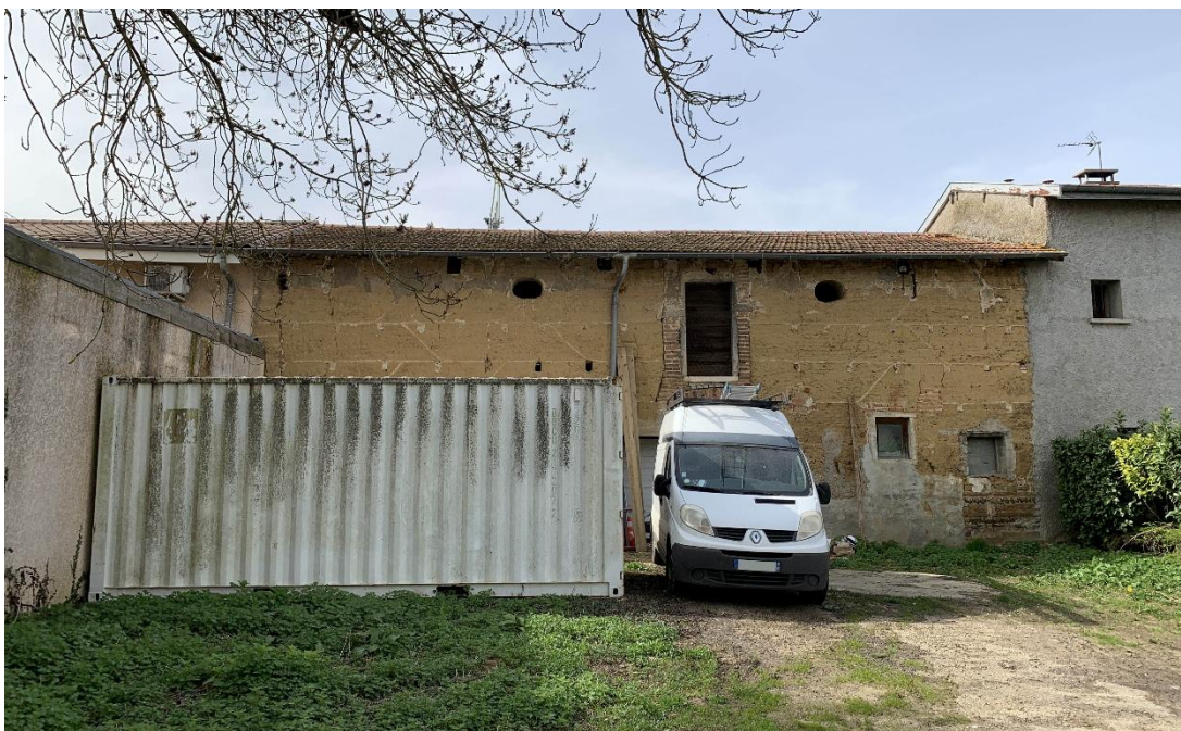
Vue sur l'un des deux bâtiments dont l'identification est demandée dans le cadre d'une contribution, à « Grande Fagne » depuis le chemin de desserte Source : photographie prise par le commissaire enquêteur
